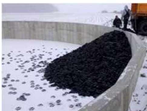
Установка покрытия в навозохранилище, замёрзшем зимой
